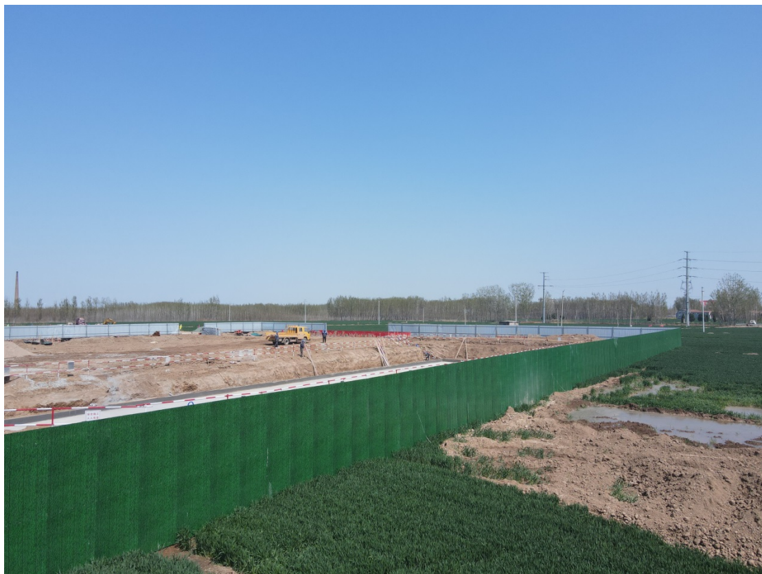
施工现场照片
